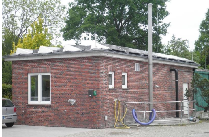
Hauptpumpwerk „Grüner Weg“
